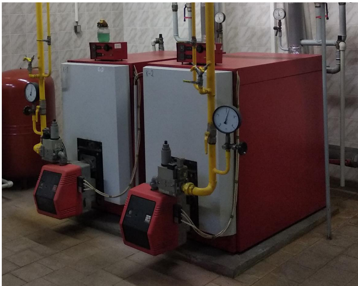
Obr. č. 4 – Stávající zdroj tepla – 2x Kotel Viadrus G300
