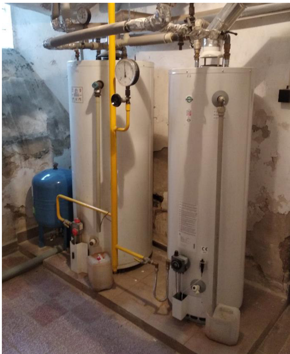
Obr. č. 5 – Stávající zdroje tepla – 2x plynový ohřivač vody 18 kW
